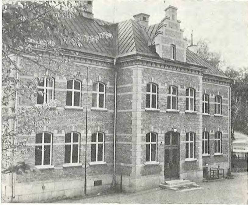
Seminariebyggnaden av 1902, Hållgatan 26, gårdssidan.
