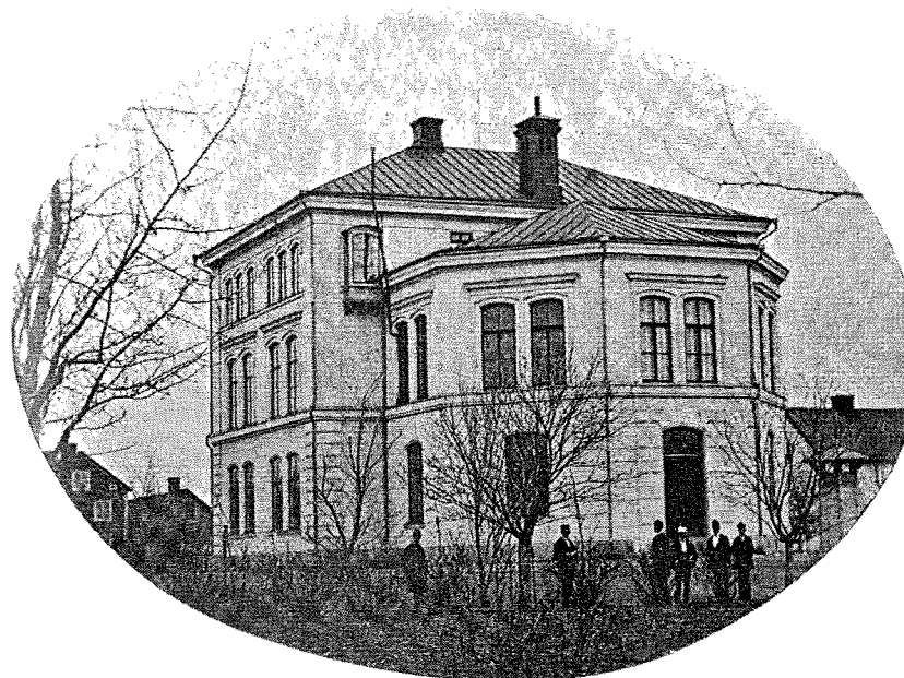
Aulan på seminariebyggnadens baksida. Foto: Privat ägo.
