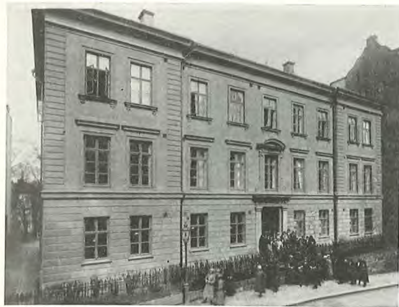
Högre lärarinnesseminariets byggnad, Riddaregatan 5.
